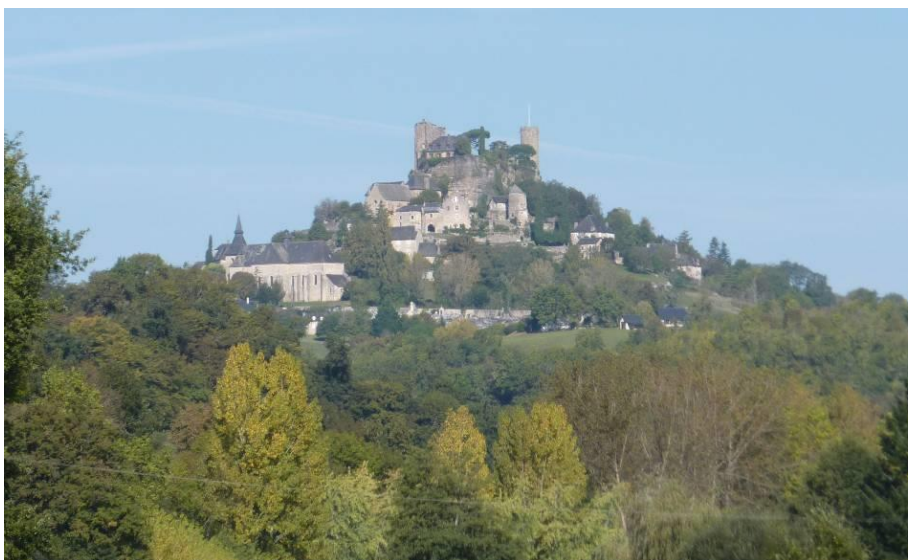
Vue depuis le site considéré : l'effet promontoire est accentué par la disposition nord/Sud de l'enceinte du château Ph BW 02/10/2014
